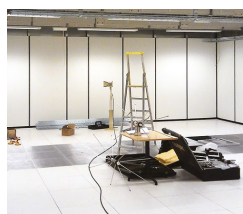
Kabina EMC w trakcie realizacji
