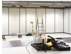
Kabina EMC w trakcie realizacji
